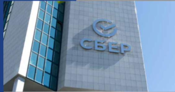
Офис «Сбербанк», Башня Б
